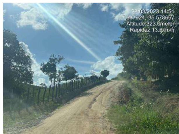
FOTO 169: INÍCIO DA TERCEIRA LADEIRA DE TANQUES – OROBÓ/PE;
