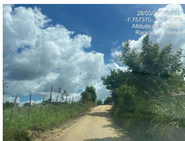
FOTO 100: INÍCIO DA QUINTA LADEIRA DO VARJÃO – OROBÓ/PE;
