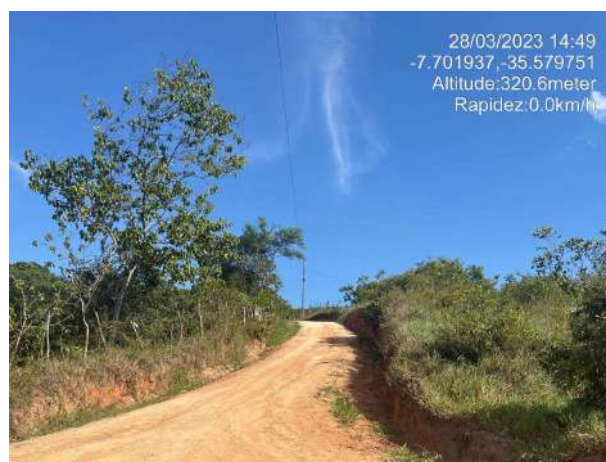
FOTO 168: SEGUNDA LADEIRA DE TANQUES – OROBÓ/PE;
