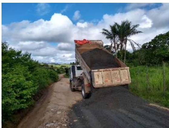
Fotos 01 e 02: descarga do material em pista
