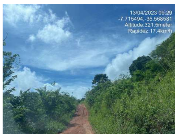
FOTO 188: CONTINUAÇÃO DA TERCEIRA LADEIRA DE FIGUEIRAS – OROBÓ/PE;
