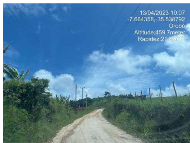
FOTO 227: INÍCIO DA SEGUNDA LADEIRA DE VIRAÇÃO – OROBÓ/PE;
