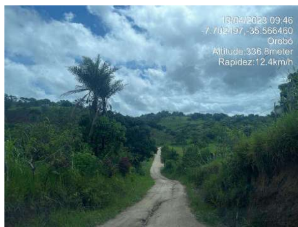
FOTO 210: CONTINUAÇÃO DA TERCEIRA LADEIRA DE FIGUEIRAS – OROBÓ/PE;
