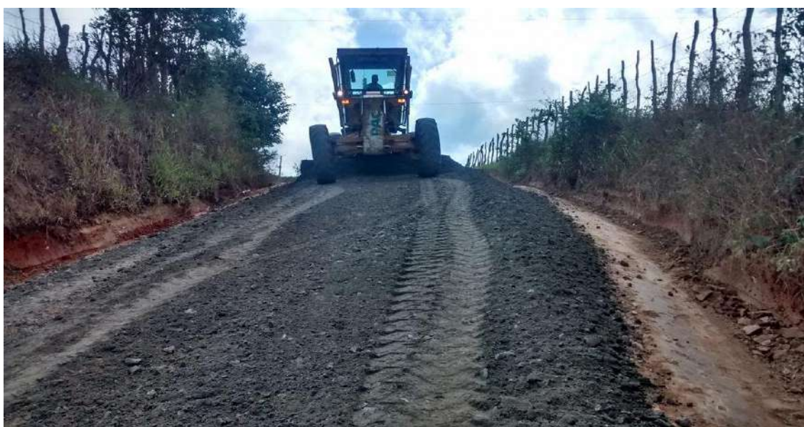
Foto 03: espalhamento do material com a motoniveladora
