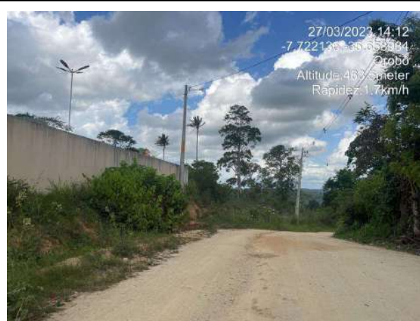
FOTO 43: TÉRMINO DA TERCEIRA LADEIRA DE PIRAUÁ – OROBÓ/PE;
