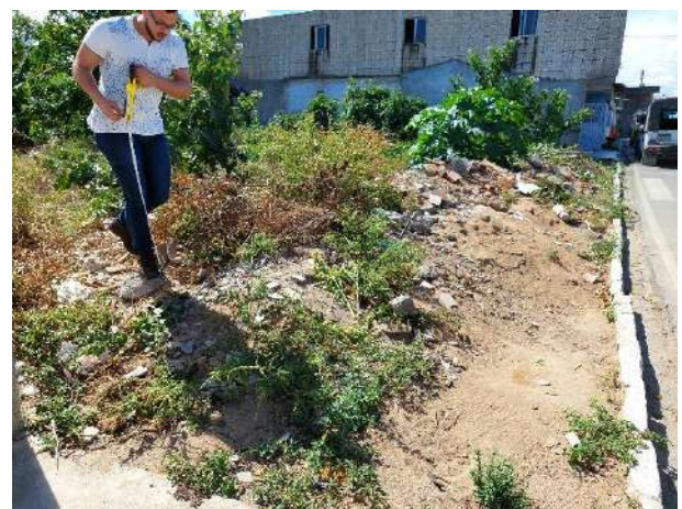
FOTO 6: Local da obra.
