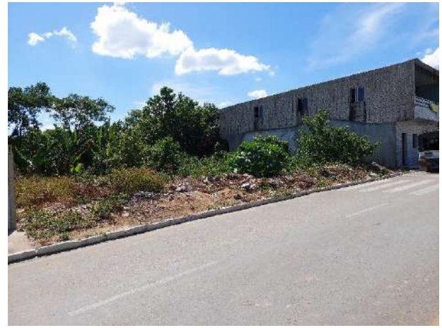
FOTO 2: Local da obra;
