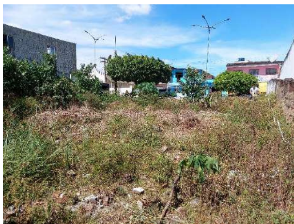
FOTO 5: Local da obra;
