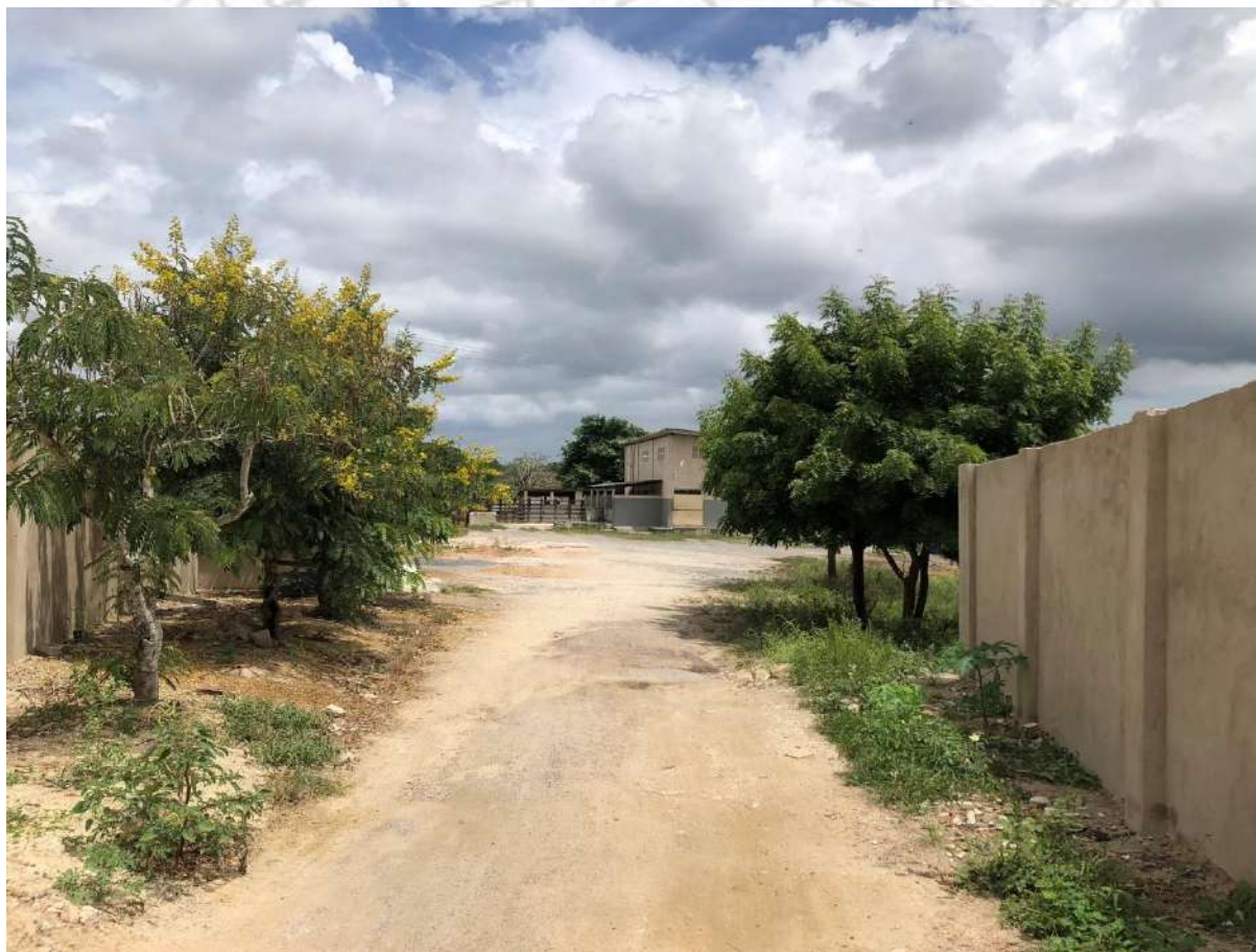
Figura 4. Vista do acesso ao Matadouro Municipal de Orobó.
