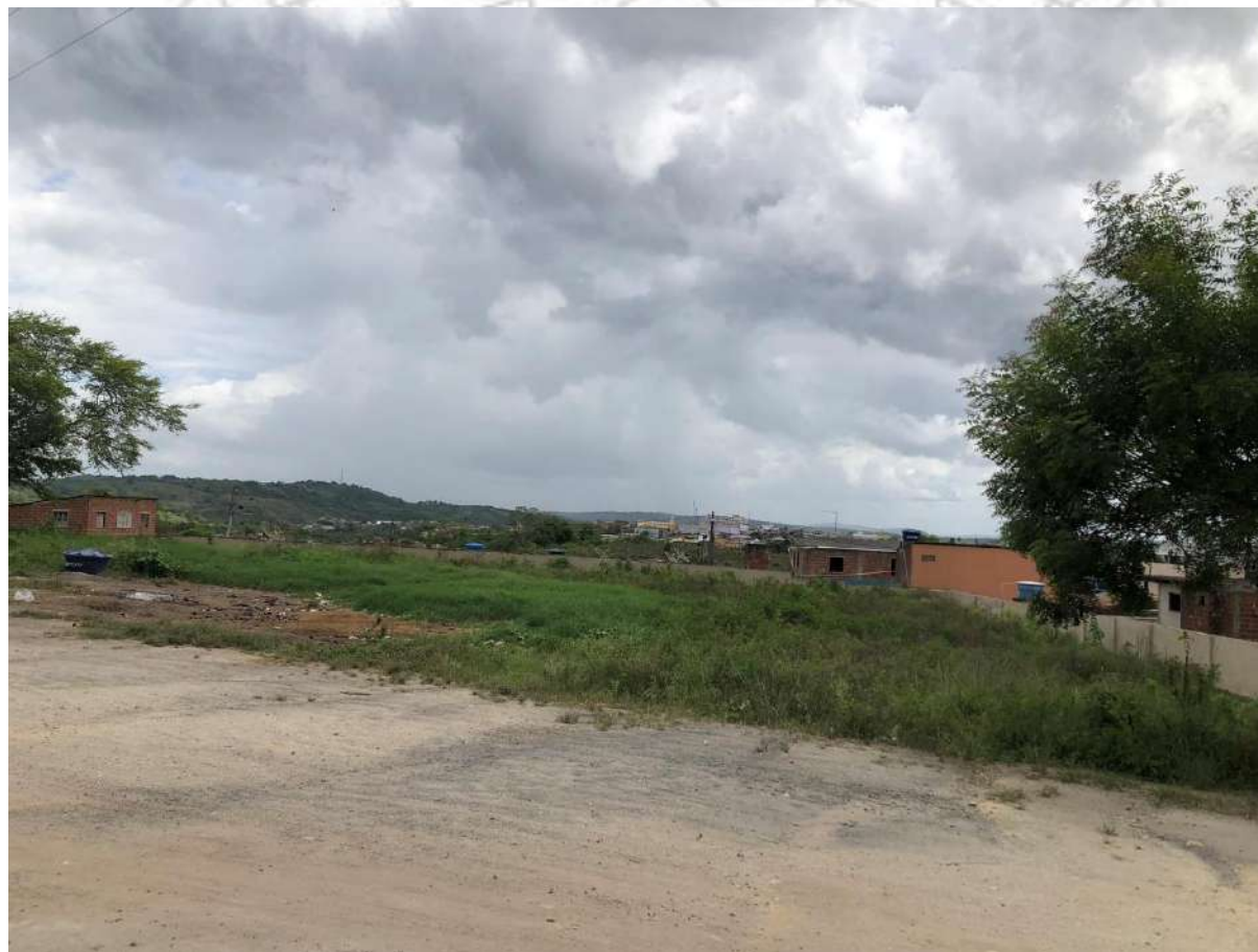
Figura 6. Vista de área livre no terreno do Matadouro Municipal de Orobó – proposta de ETE e Esterqueira.
