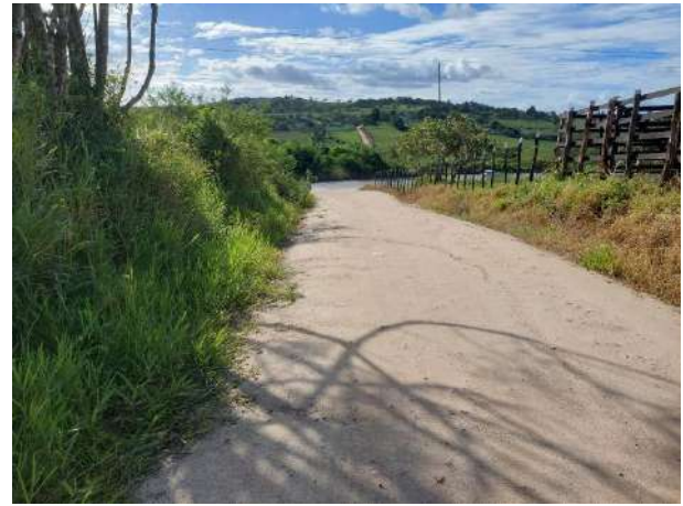
FOTO 8: Estrada de acesso a Feira Nova;
