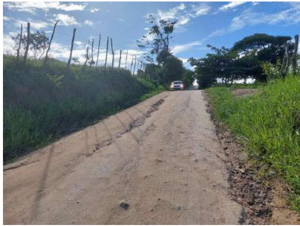
FOTO 1: Estrada de acesso a Feira Nova;
