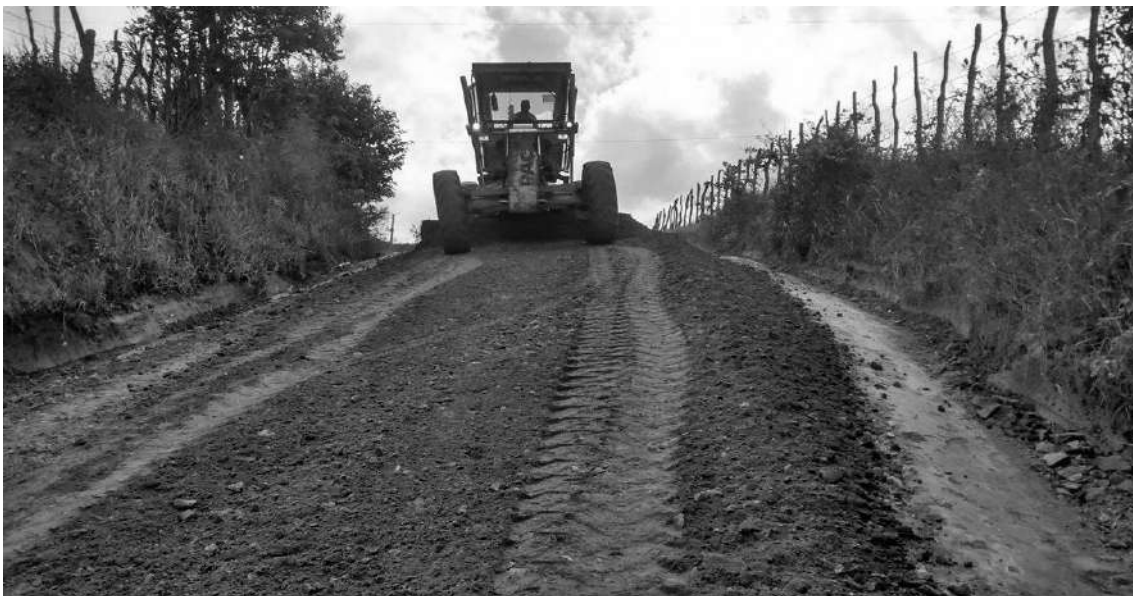
Foto 03: espalhamento do material com a motoniveladora
