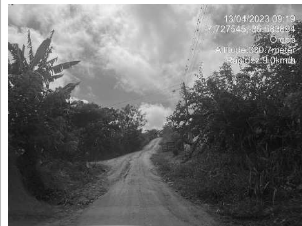
FOTO 179: INÍCIO DA TERCEIRA LADEIRA DE OLHO D'ÁGUA SECO – OROBÓ/PE;
