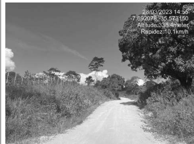
FOTO 171: INÍCIO DA QUARTA LADEIRA DE TANQUES – OROBÓ/PE;
