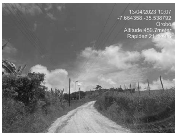
FOTO 227: INÍCIO DA SEGUNDA LADEIRA DE VIRACÃO – OROBÓ/PE;
