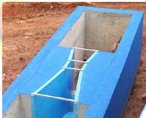
Figura 31. Calha Parshall.
