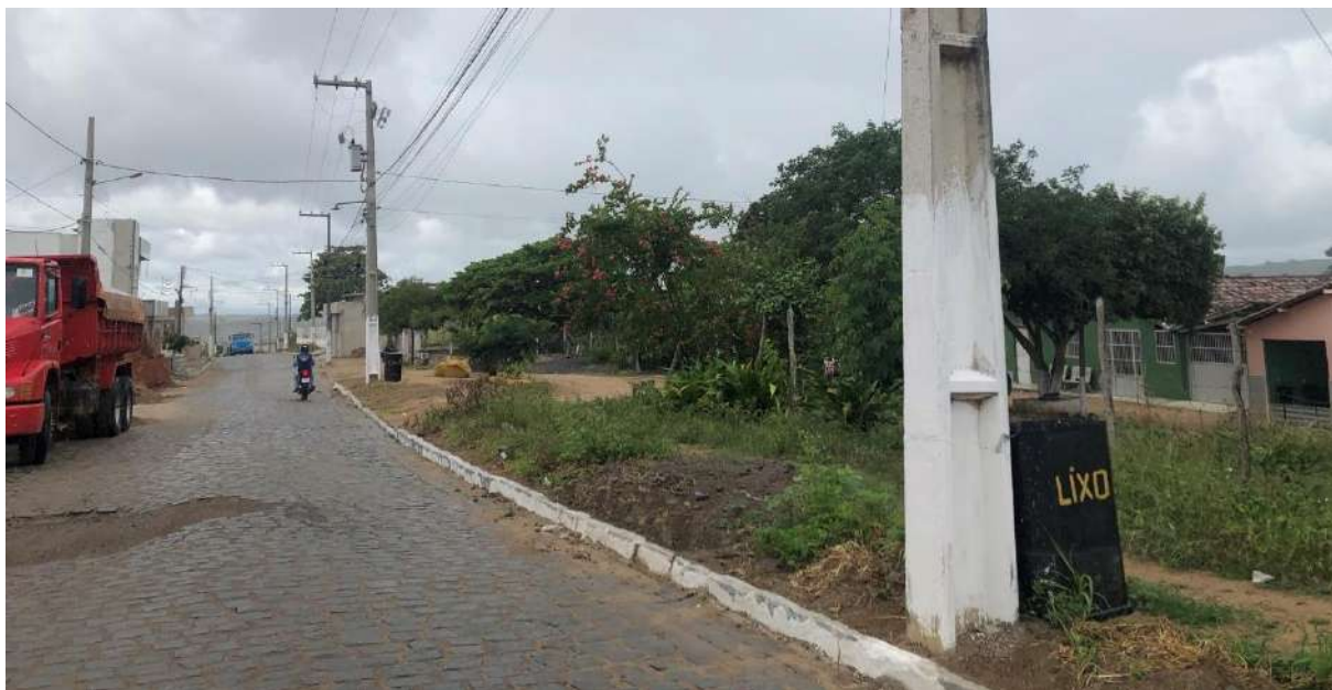
Figura 18. Leito carroçável em cota mais elevada que os lotes com contribuições na Zona A.
