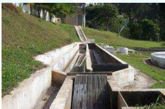
Figura 30. Gradeamento e desarenador.
