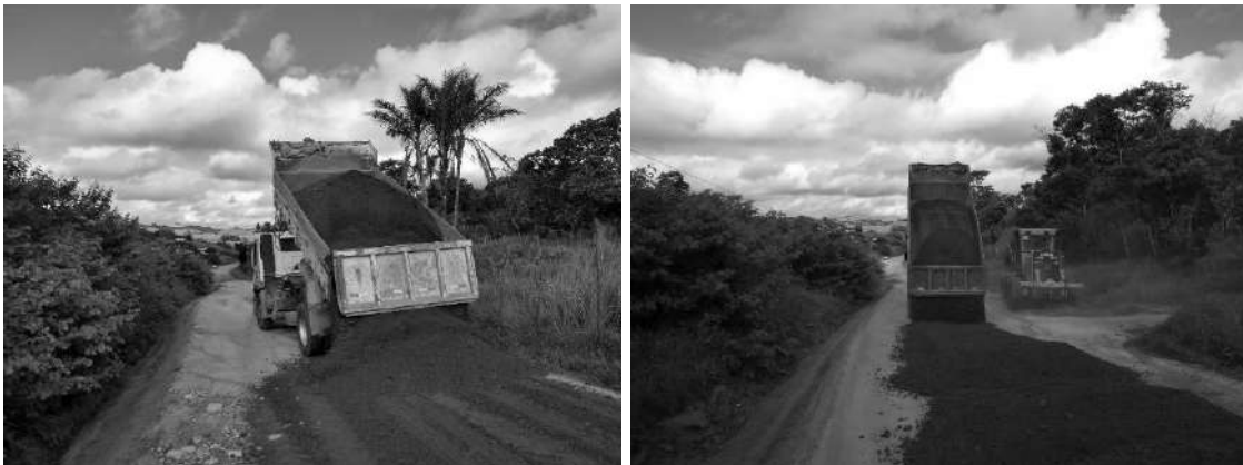
Fotos 01 e 02: descarga do material em pista
