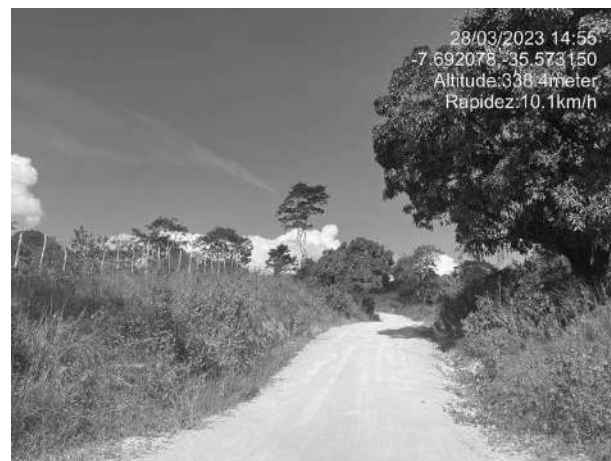
FOTO 171: INÍCIO DA QUARTA LADEIRA DE TANQUES – OROBÓ/PE;
