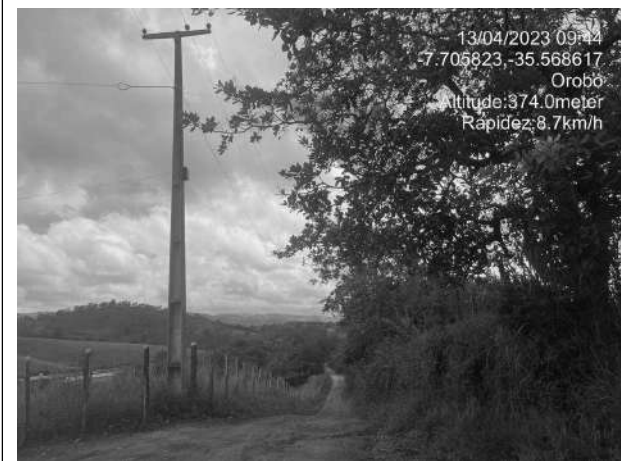
FOTO 207: INÍCIO DA SEGUNDA LADEIRA DE FIGUEIRAS – OROBÓ/PE;
