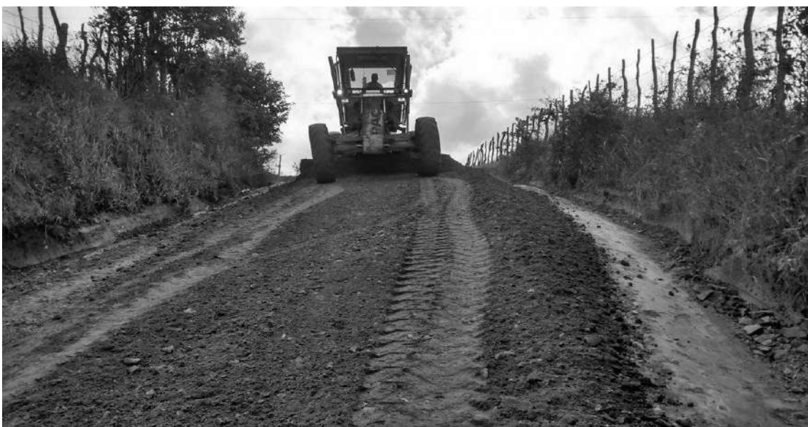
Foto 03: espalhamento do material com a motoniveladora
