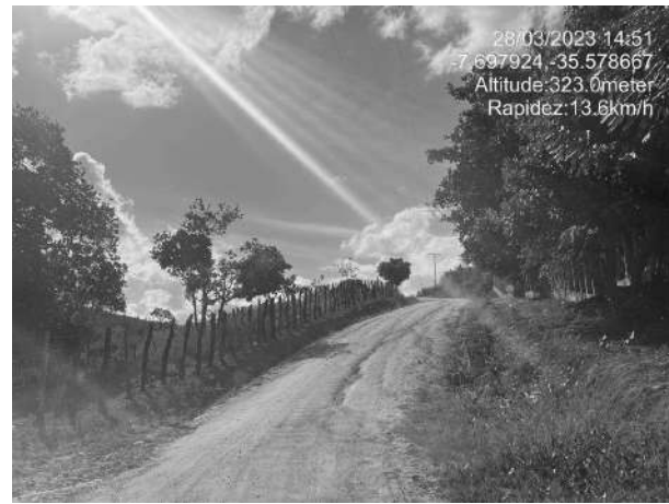
FOTO 169: INÍCIO DA TERCEIRA LADEIRA DE TANQUES – OROBÓ/PE;
